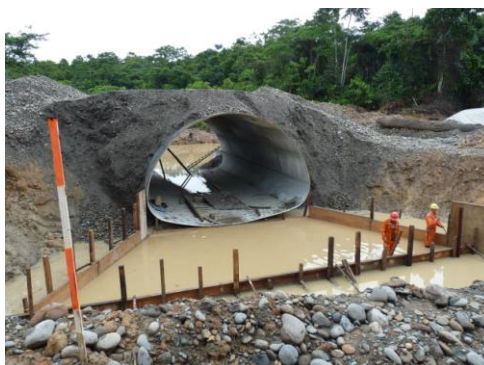
En plena construcción de la carretera
