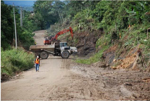
Foto: trabajos avanzan en la carretera Tena-Río Jondachi © www.mtop.gov.ec
